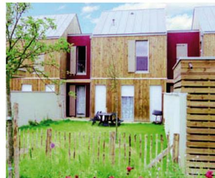
**Energie** Construction à ossature bois, isolation renforcée, chauffage électrique par panneaux à fluide caloporteur.
