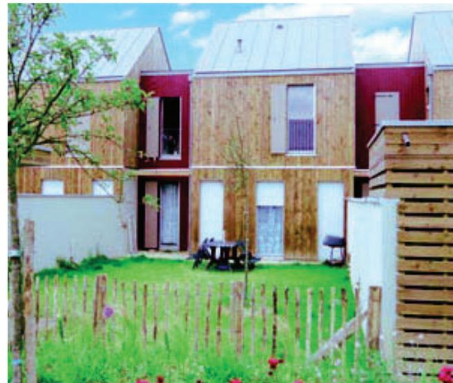
**Energie** Construction à ossature bois, isolation renforcée, chauffage électrique par panneaux à fluide caloporteur.
