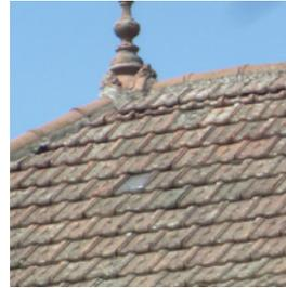
Tuile mécanique losangée
